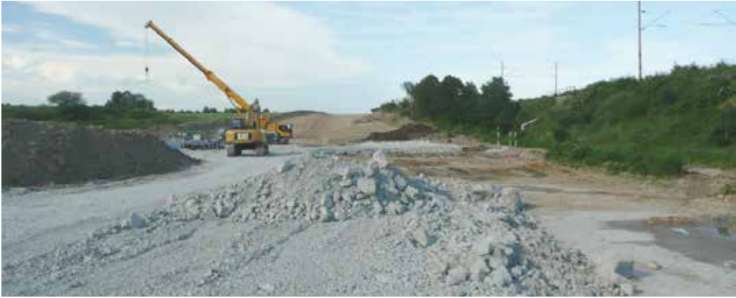
Stavba dálnice mezi Bošilcem a Ševětínem.
