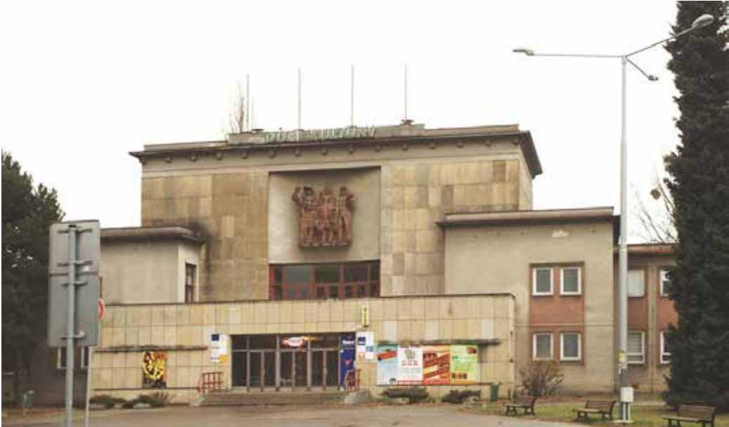
S rekonstrukcí Domu kultury počítá letošní ostravský rozpočet.
