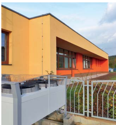
Objekt doznal změn z pohledu praktického využití, energetické úspory i veselého vzhledu.
