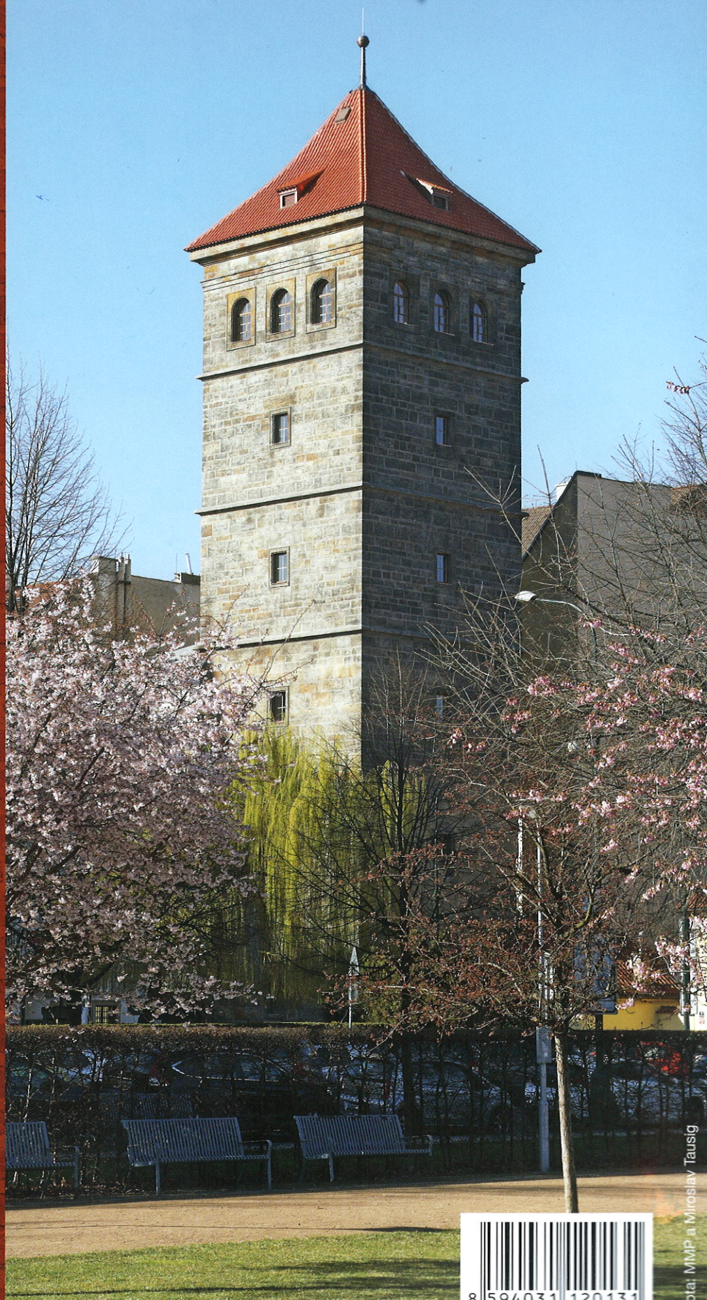
Novomlýnská vodárenská věž, Praha 1
